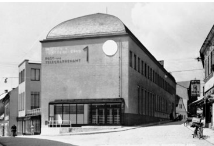
Poštovní a telegrafní úřad Šumperk, postavený dle návrhu Ernsta Wiesnera. Pohlednice z období okupace, na níž je patrný smazaný český nápis. Zdroj: sbírka Vlastivědného muzea Šumperk.
