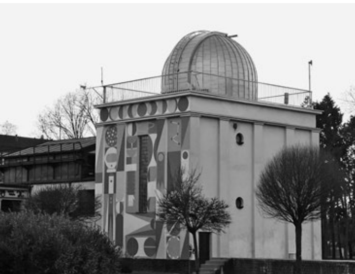
Budova prostějovské hvězdárny. Foto: Petra Pášová.
