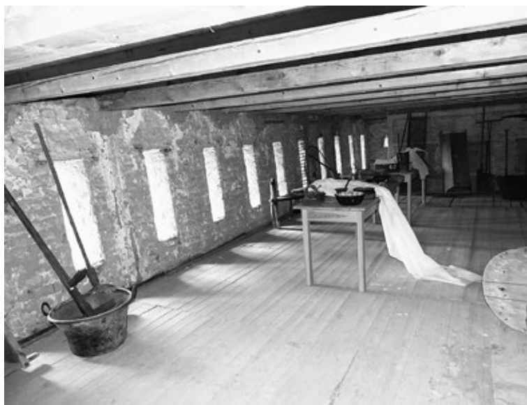
První patro v sušárně v Odrlicích. Foto: archiv autora.
